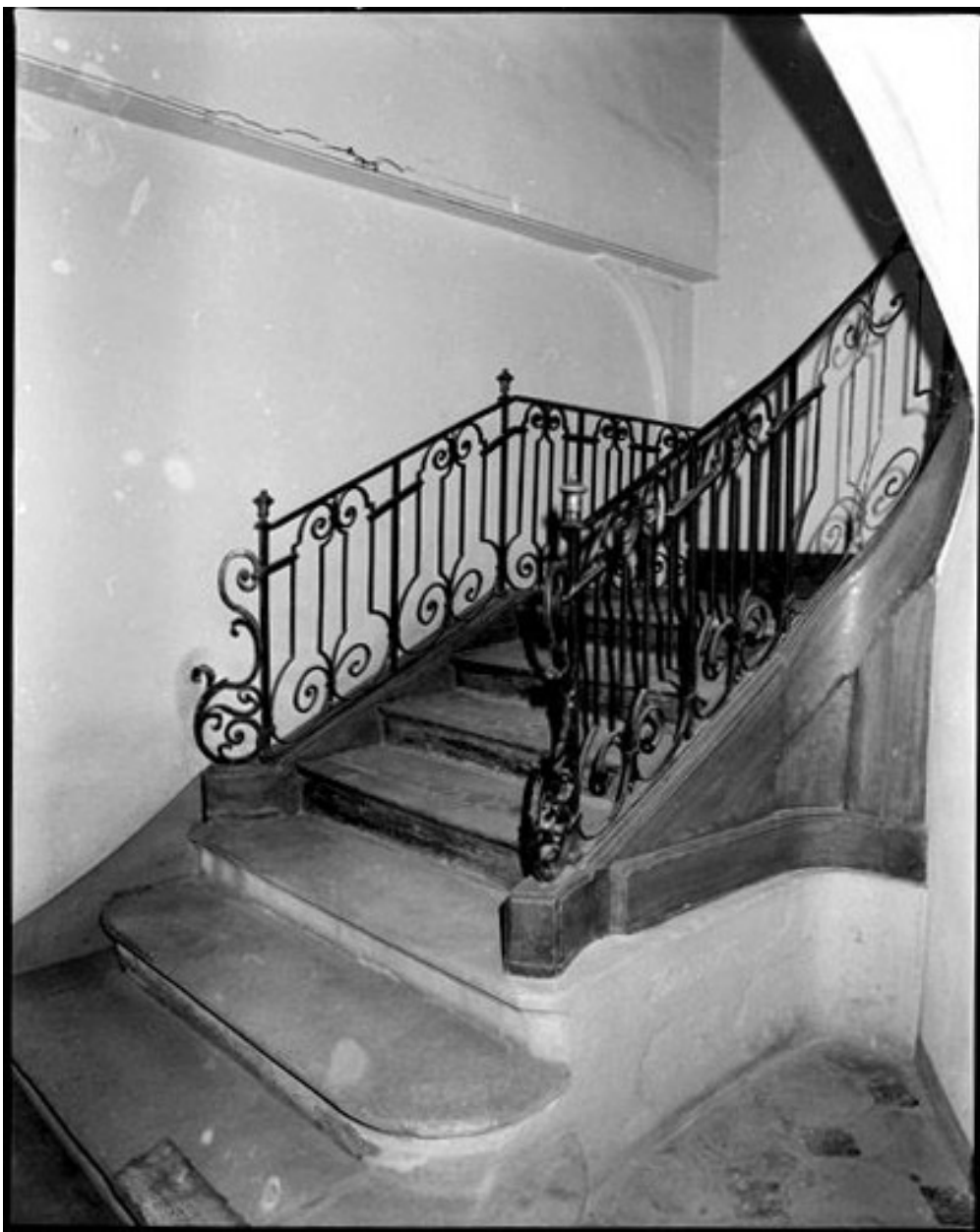
Maison (détruite), Sangle (rue de la) 35. L'escalier à rampe de serrurerie.
