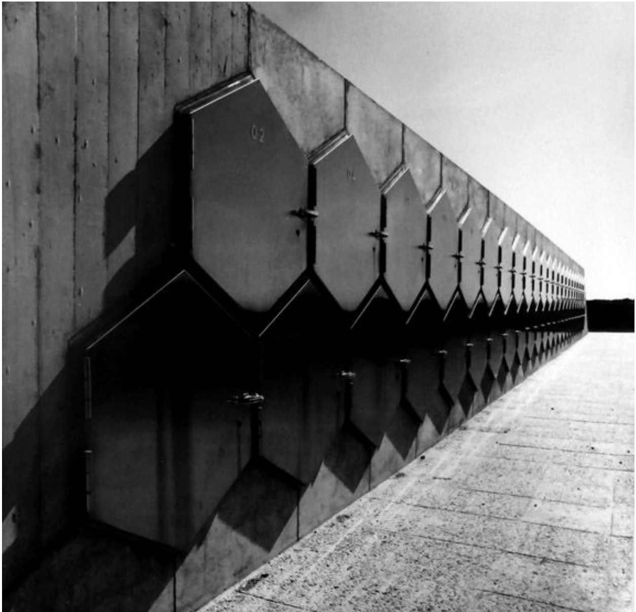
Vue d'un rang de dépositoires, conçu selon le principe alvéolaire breveté par Auzelle. Photographie NB, [1973].
