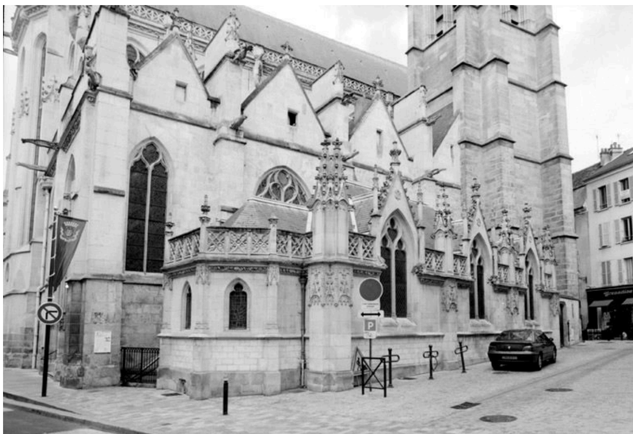
Élévation nord, sur la rue Sébastien-Roulliard, avec la sacristie néo-gothique.
