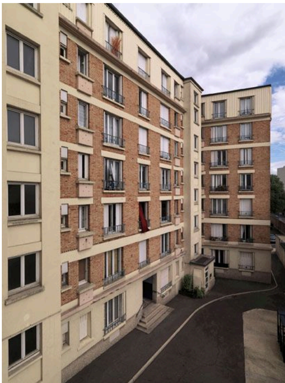
Cité du Foyer des Invalides et des Anciens Combattants. Vue de l'arrière d'un bâtiment, construit en 1931. E. Thomas et Pavot (architectes).
