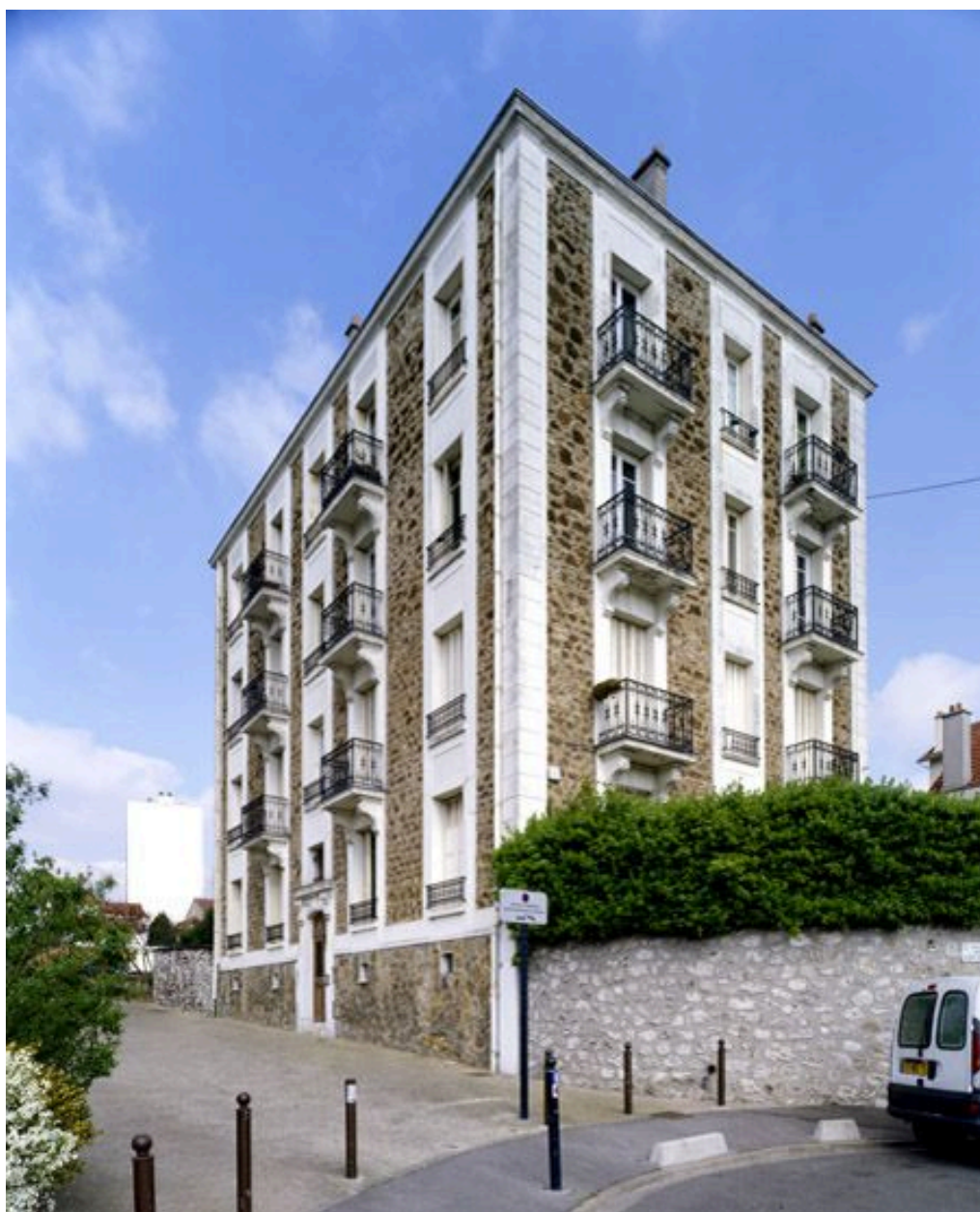
Immeuble, 2 rue guy Môquet. Vue d'ensemble de l'immeuble, isolé dans sa parcelle.
