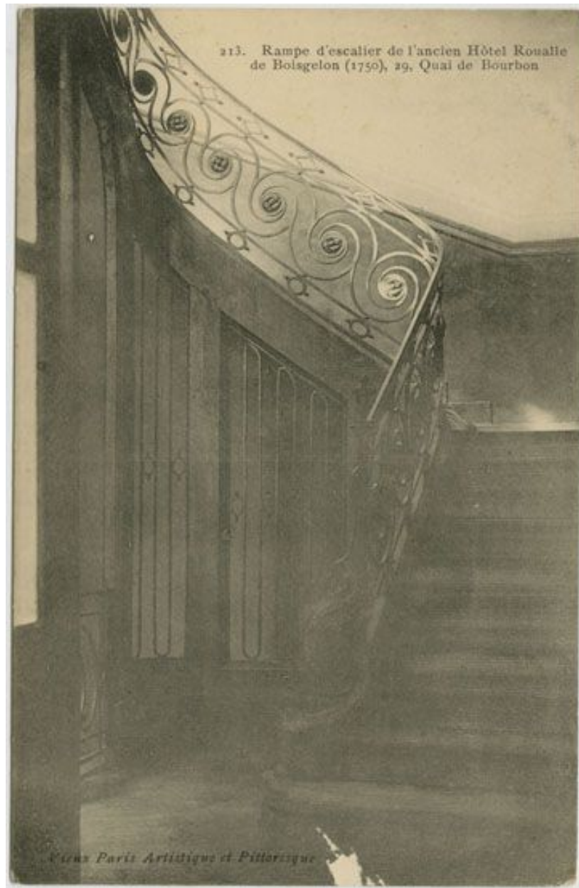
Vue d'ensemble de l'escalier, 29, quai de Bourbon. Carte postale. (Collection particulière)
