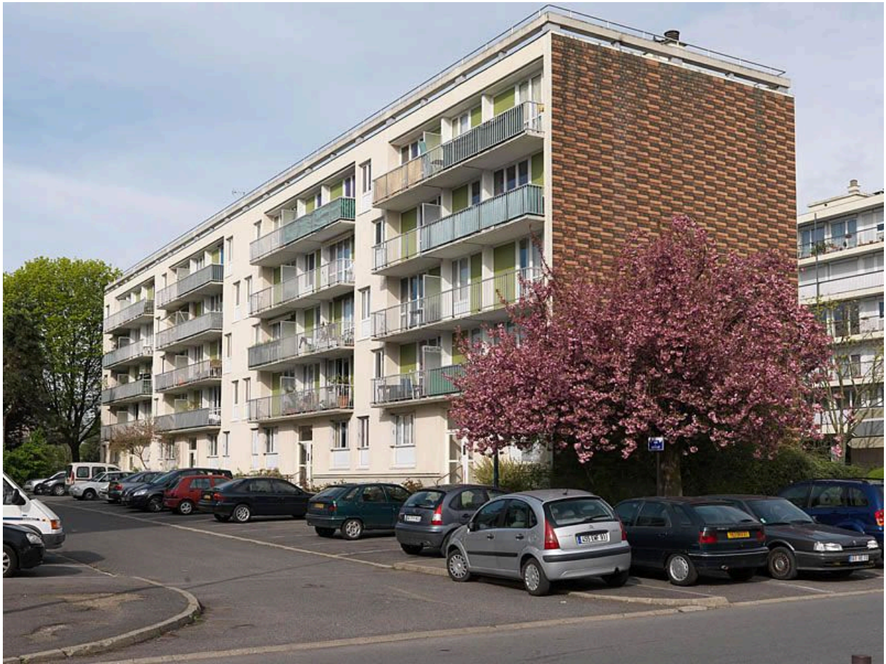
Façade et pignon d'une des deux barres R+4 situées sud-ouest du grand ensemble, excentrées du reste de l'opération. Le pignon est recouvert de bois de différentes teintes.
