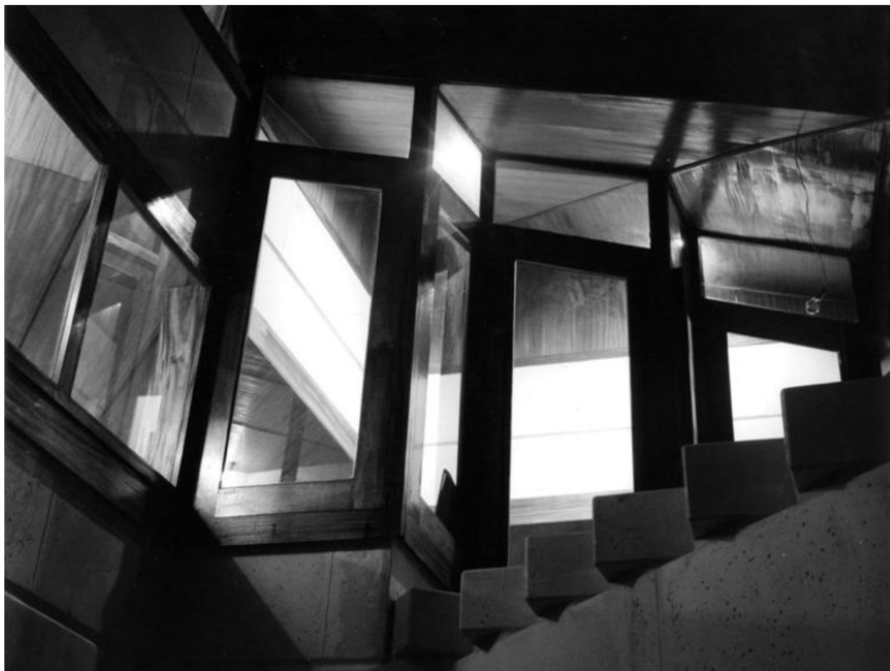
Détail des fenêtres du premier étage (vue ancienne).
