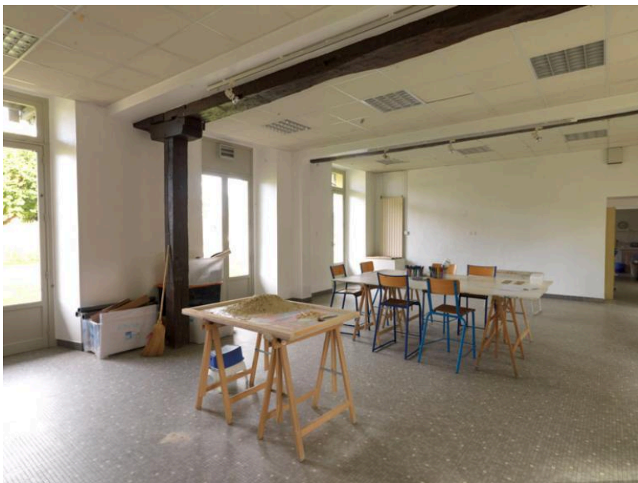
Vestige de poutre, rez-de-chaussée.
