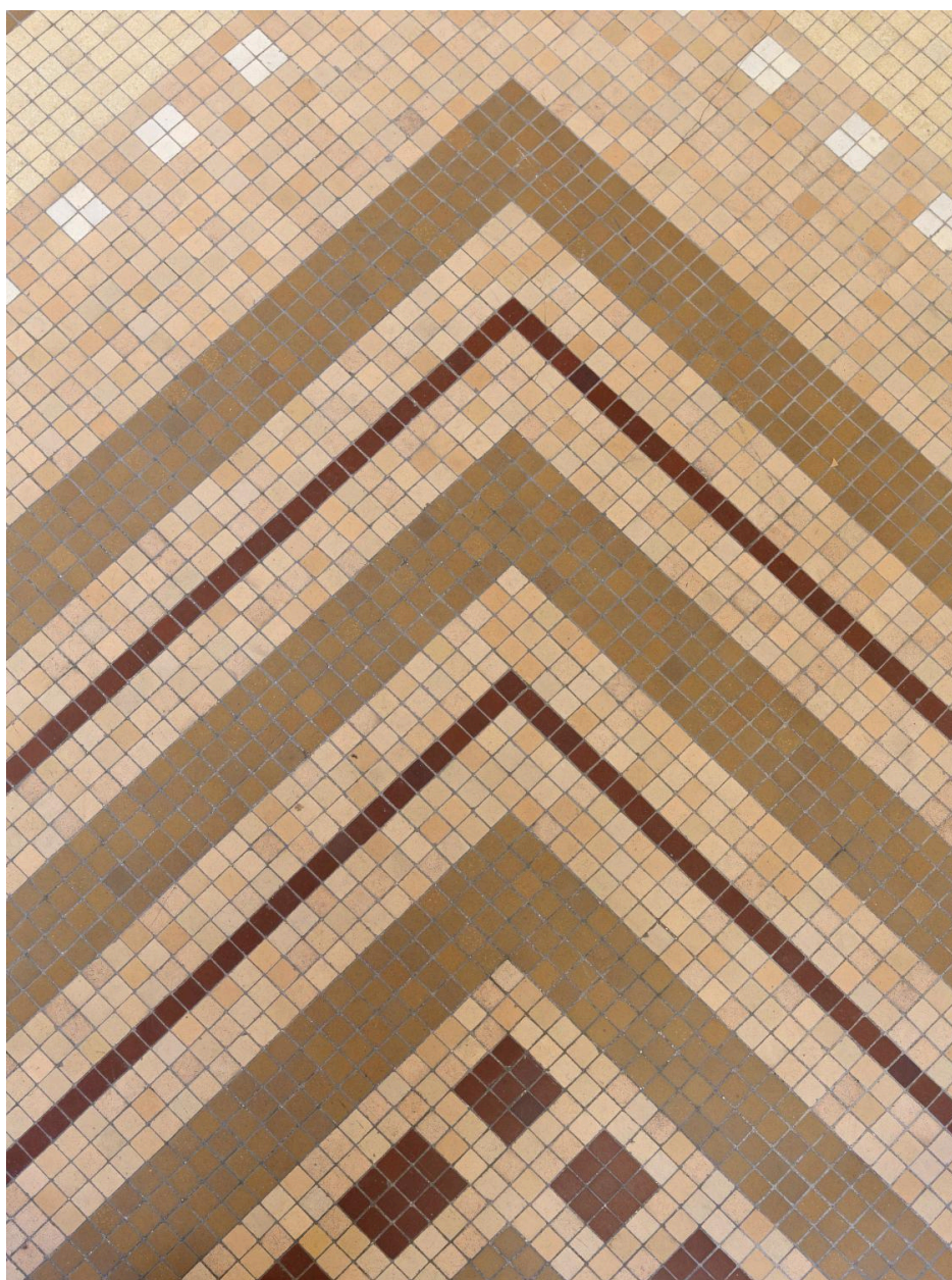
Détail du sol du hall d'honneur du lycée.
