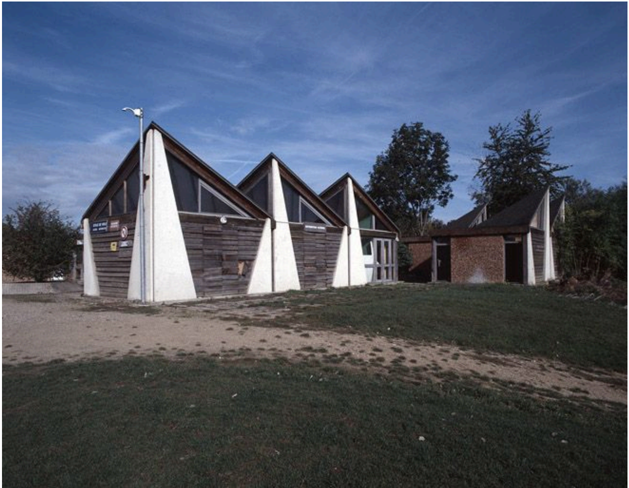
Bâtiments près de l'accès au port : salle "Christophe-Colomb".
