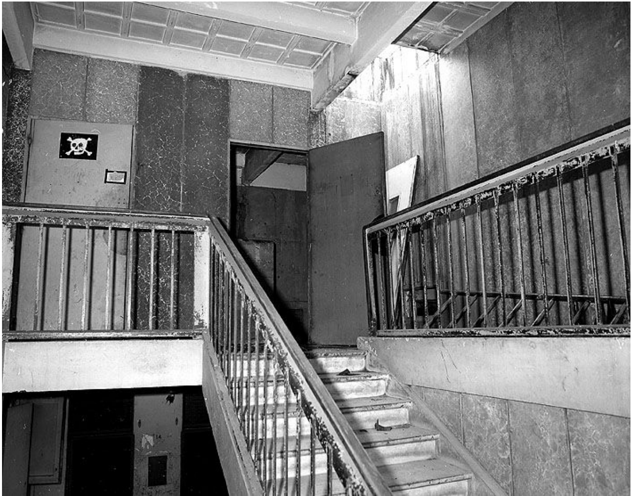
Tour 1, 15ème étage, cage d'ascenseur. Campagne photographique, lors de la destruction du bâtiment en 1976.
