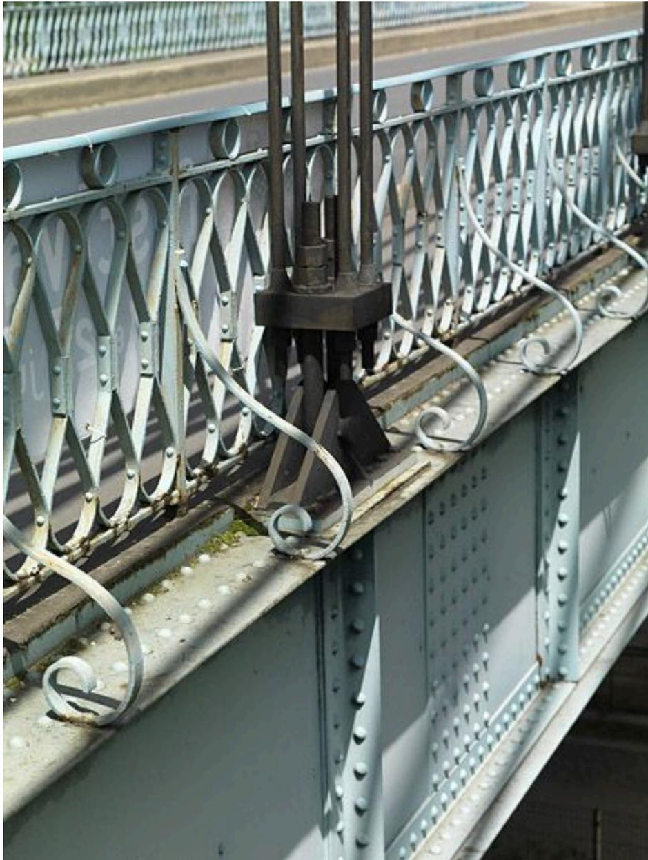
Vitry-sur-Seine, Alfortville. Pont de Port-à-l'Anglais. Détail de la balustrade en fer plat riveté.
