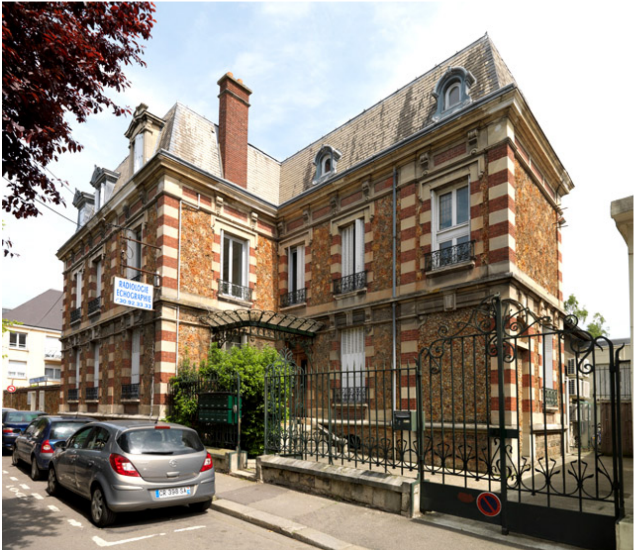
Maison de notable, 2 avenue Léon-Marie-Cesne. La façade sur rue.
