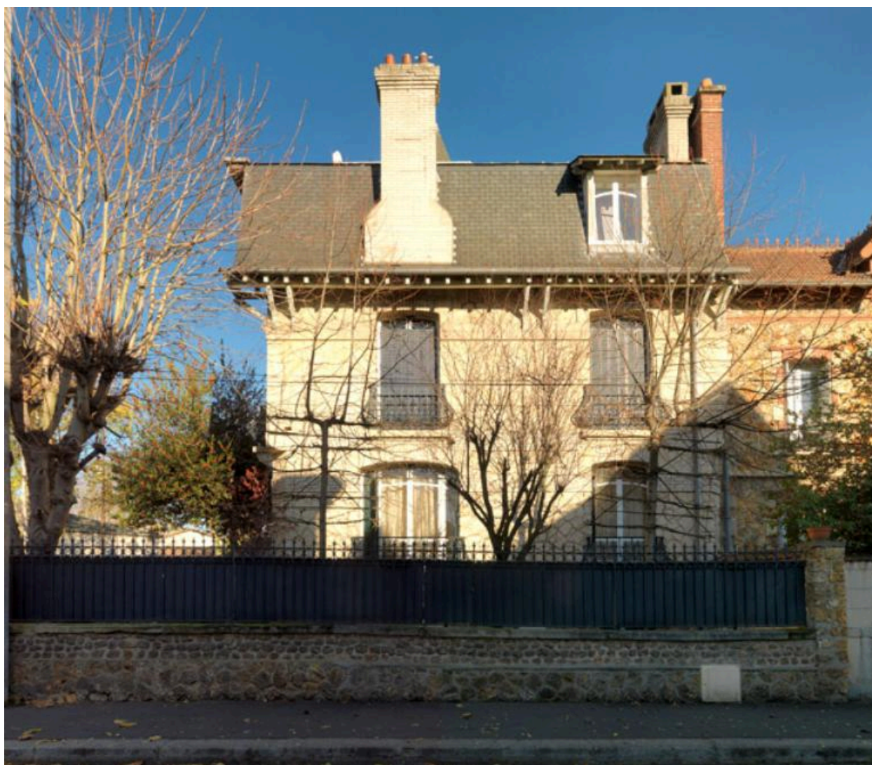
Façade latérale de la maison. On voit que sa façade arrière est mitoyenne.
