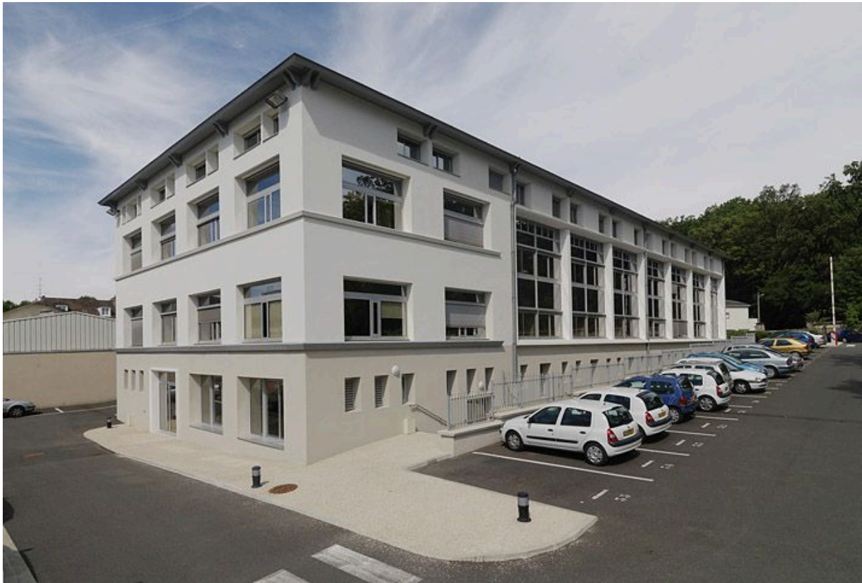
Ancienne station d'essais PIC, depuis le sud-est.
