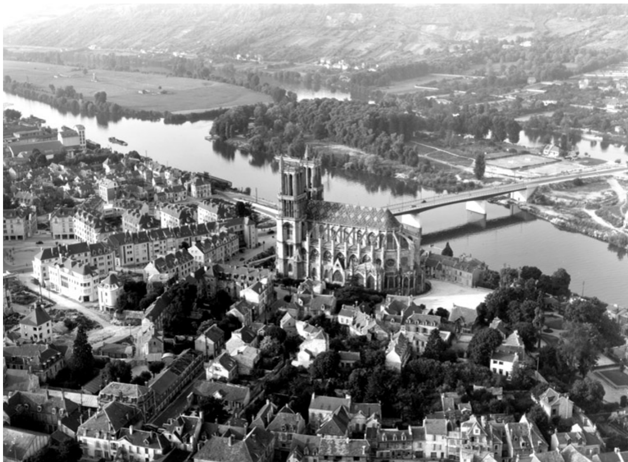
Vue du quartier de la collégiale reconstruit. (Cliché Henrard).
