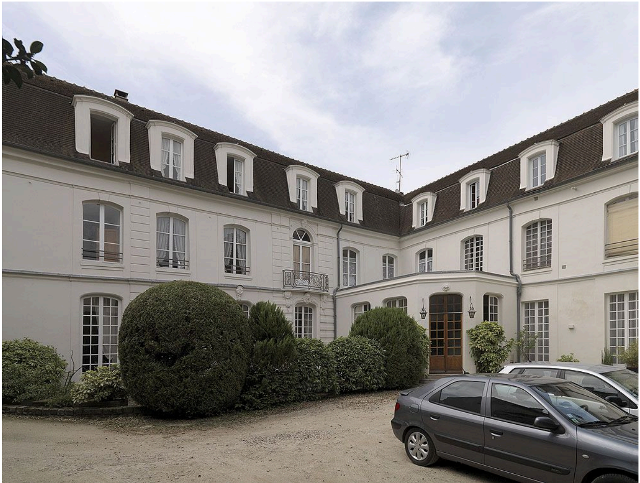
Le corps de logis sur cour : ailes sud et ouest. Vue prise depuis l'angle nord-est de la cour.
