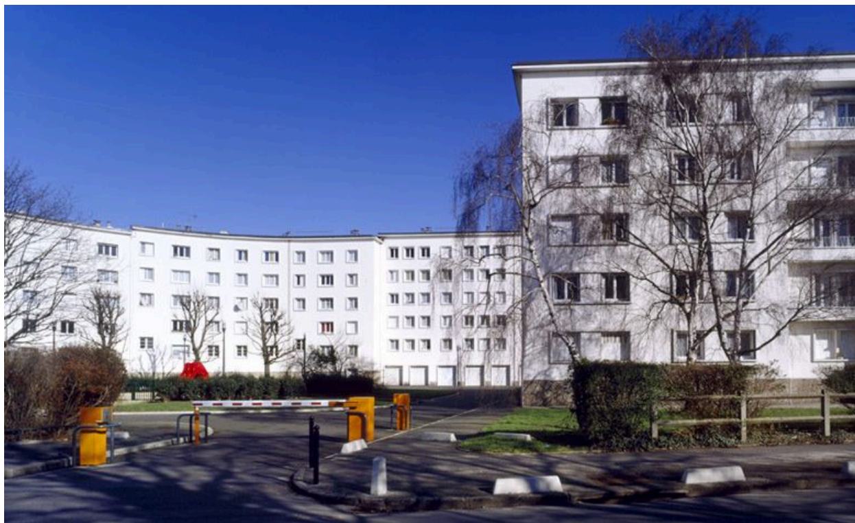
Cité Blanche, boulevard Jules Guesde. Paul Pelletier et Michel Feuillas (architectes). Vue des bâtiments depuis le boulevard Jules-Guesde.
