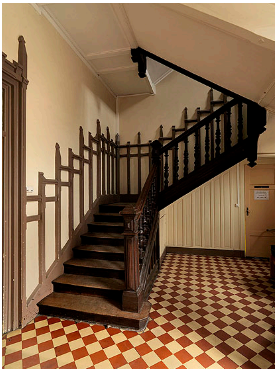
Vue des premières volées de l'escalier depuis le palier du rez-de-chaussée.
