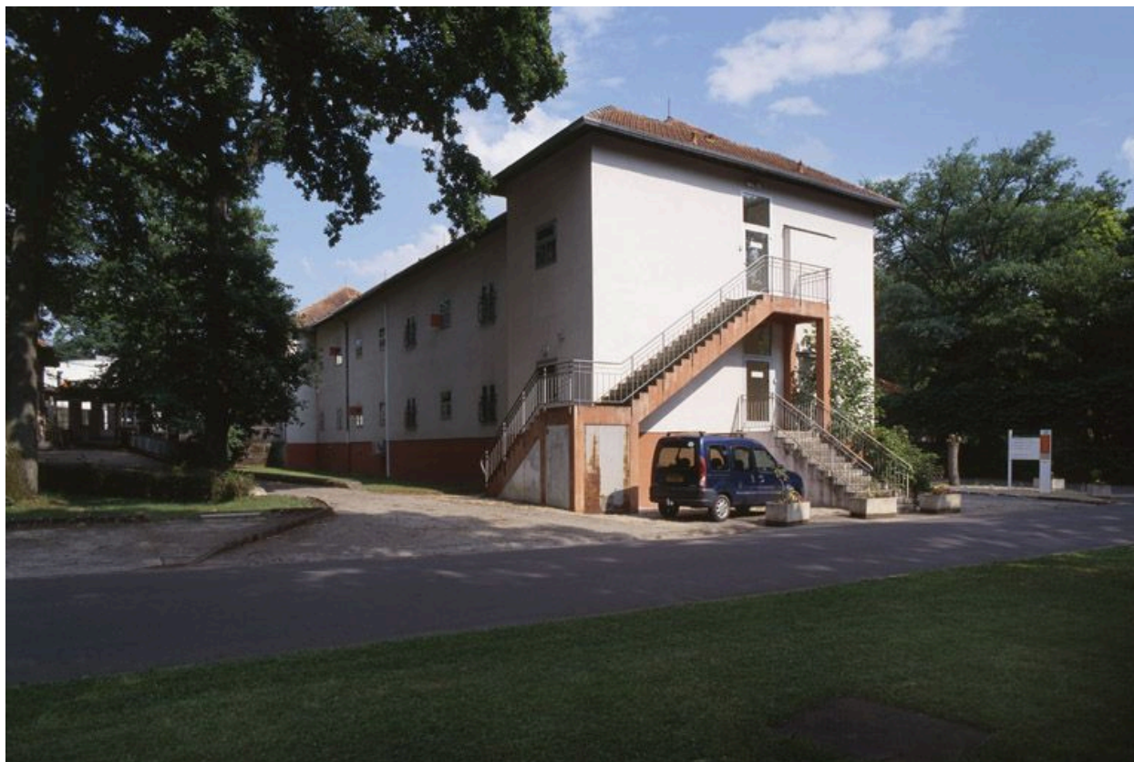
Mur-pignon de la division René-Laennec.
