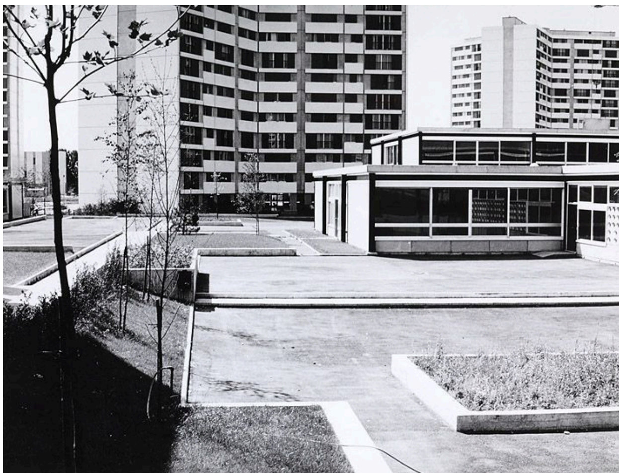
Groupe scolaire (école maternelle) au pied d'une des tours de Beauval. (Cité de l'architecture et du patrimoine. fonds DAU 173/1)
