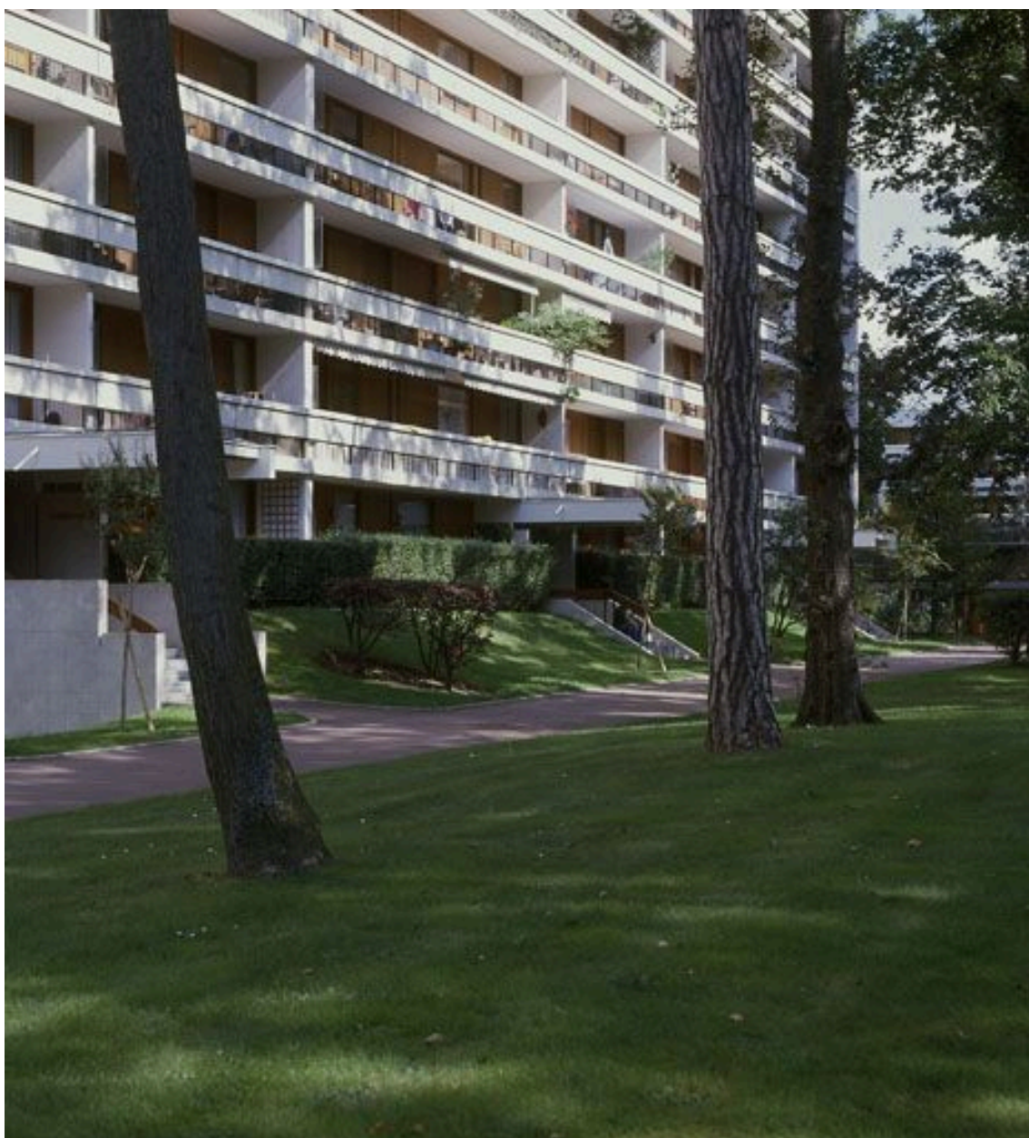
Un des 4 immeubles R+8 en forme de barre : détail de la façade sur le parc.
