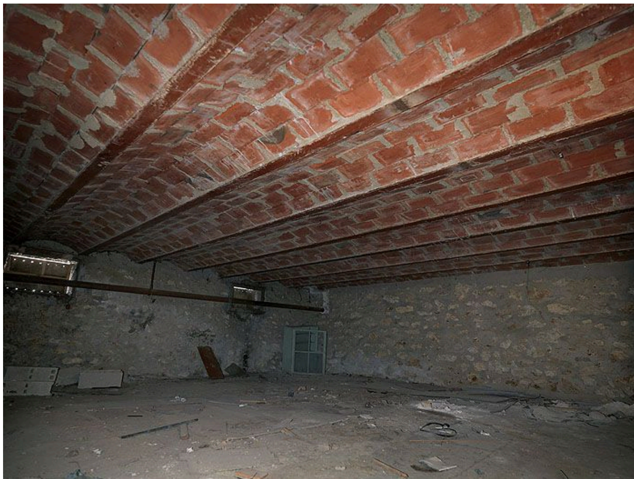
Une cave de l'aile des classes, avec ses voûtaines de briques.
