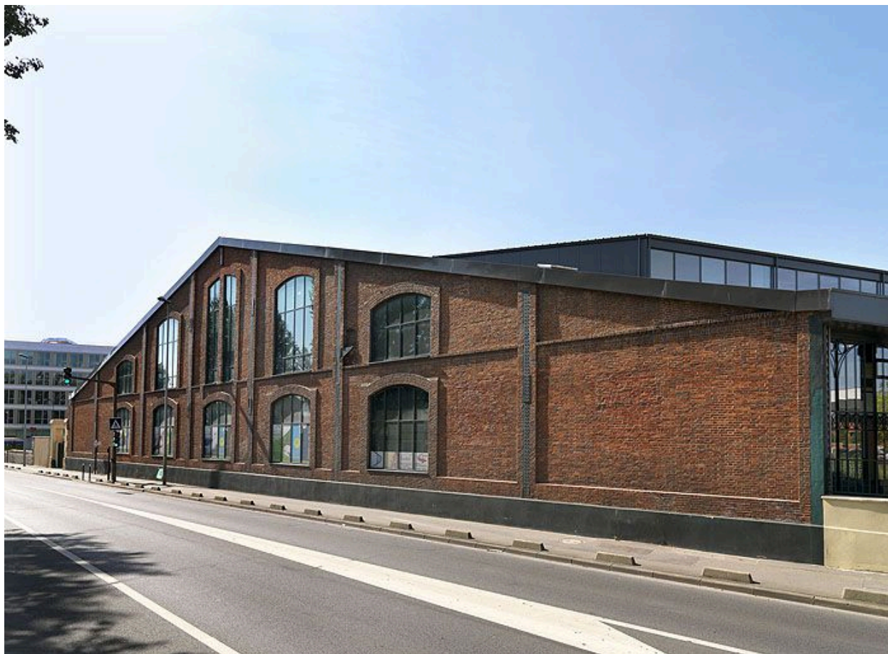
93, Saint-Denis, usine de petite métallurgie dite Société Téfimétaux, 72 rue Ambroise-Croisat. Vue d'ensemble de la façade du pignon sur la rue.
