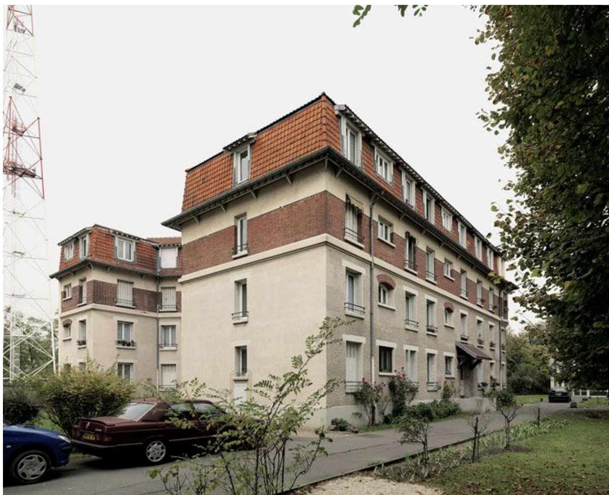
Logements collectifs, rue Vassou.
