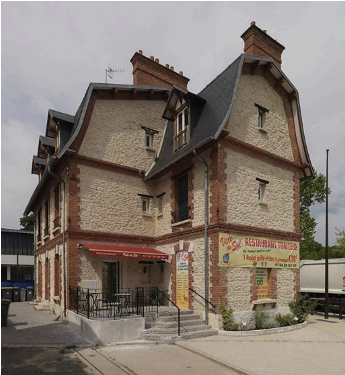
Maison de contremaître, actuellement restaurant et logements.
