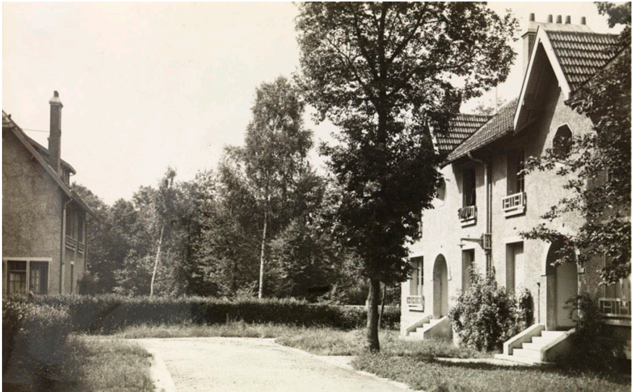
Le pavillon affecté au logement des médecins. (Archives de l'Assistance publique, 3 Fi 3/20)
