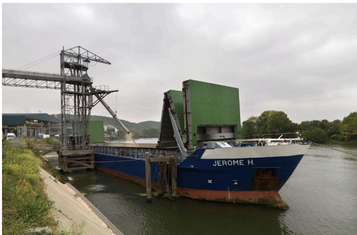
Bonnières-sur-Seine, silos de la Société anonyme des silos de Bonnières, quai de Seine. Chargement d'une péniche.
