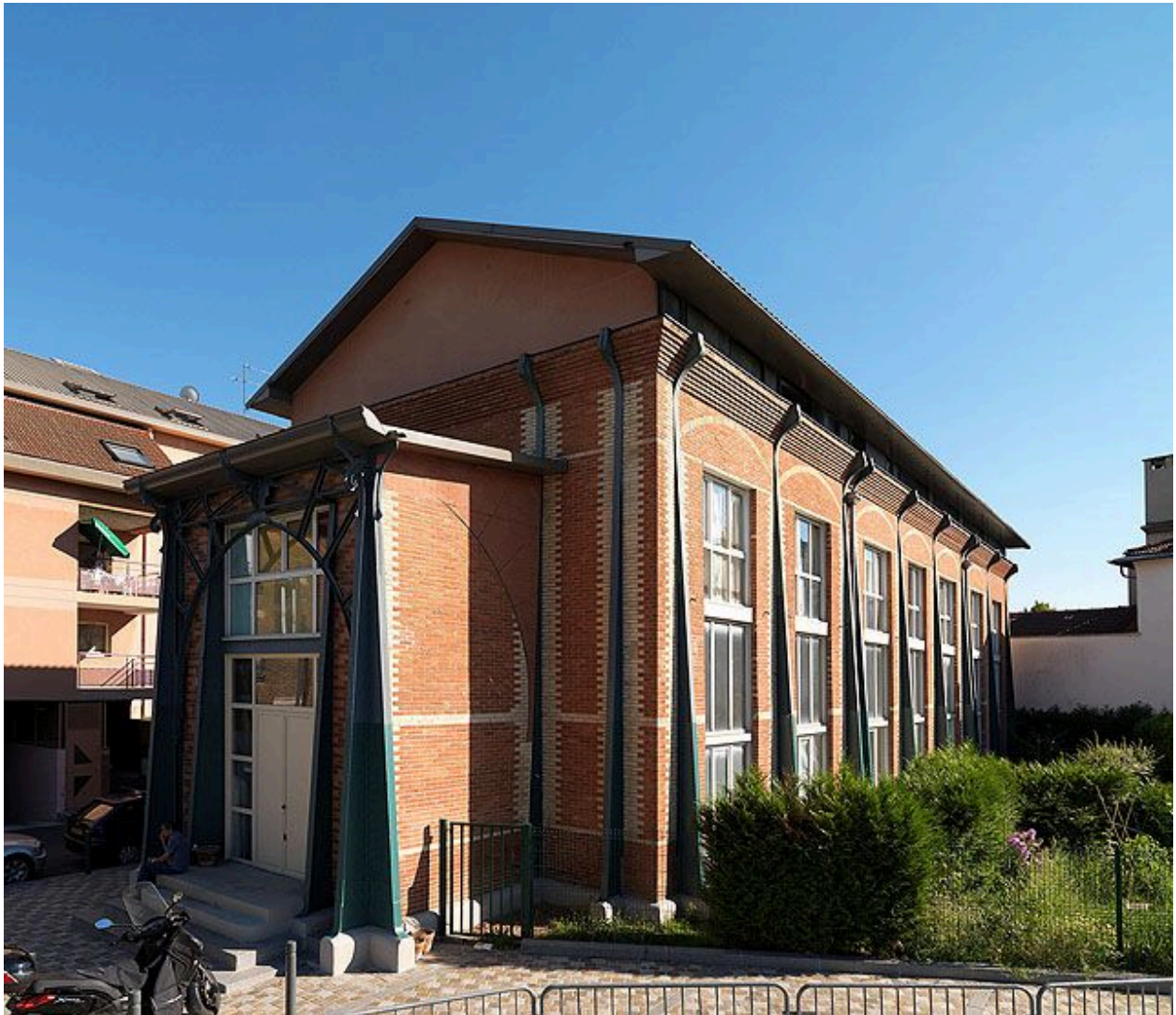
93, Saint-Ouen, pavillon d'exposition 1900 dit Pavillon de Liège, impasse Germaine. Vue d'ensemble du pavillon après modifications.
