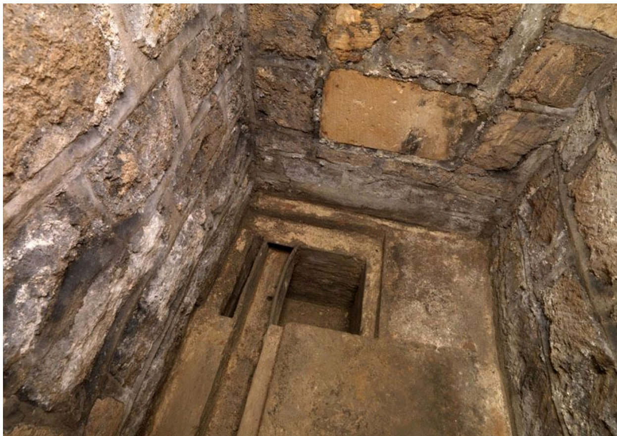
Paris 14e, René-Coty (avenue) 10. Vue de la concession d'eau pour l'hôpital la Rochefoucauld dans le regard XXV.
