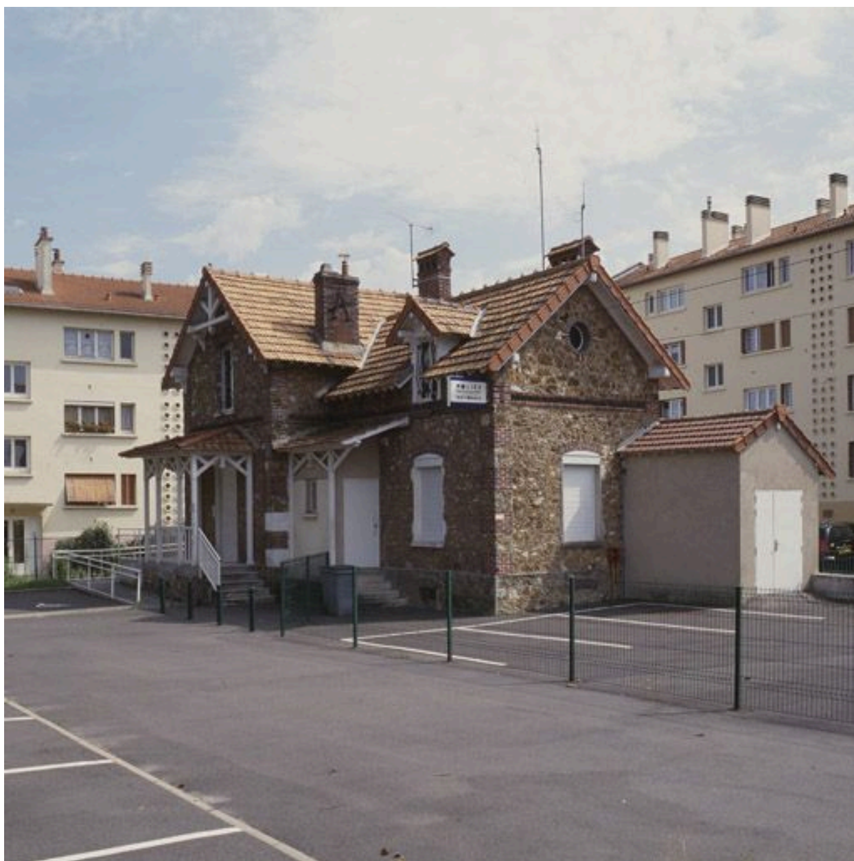
Vue de l'édifice entre les immeubles de la cité Marion.
