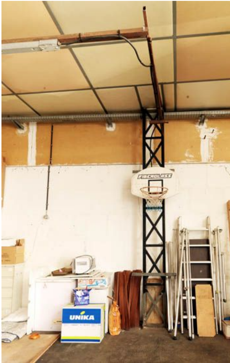
Vue intérieure de l'ancien atelier d'usinage, structure métallique porteuse.
