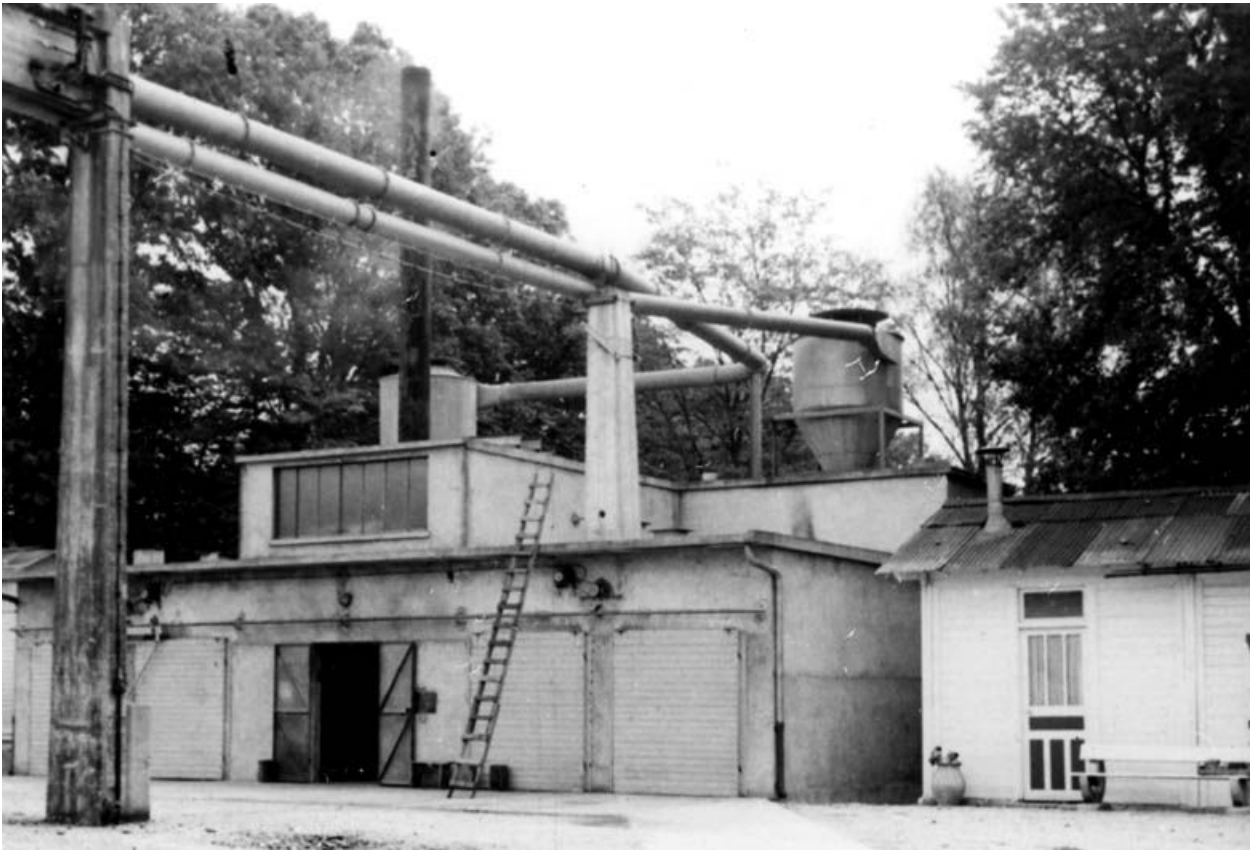
Vue des nouveaux séchoirs depuis le nord. Photographie. (Collection particulière)
