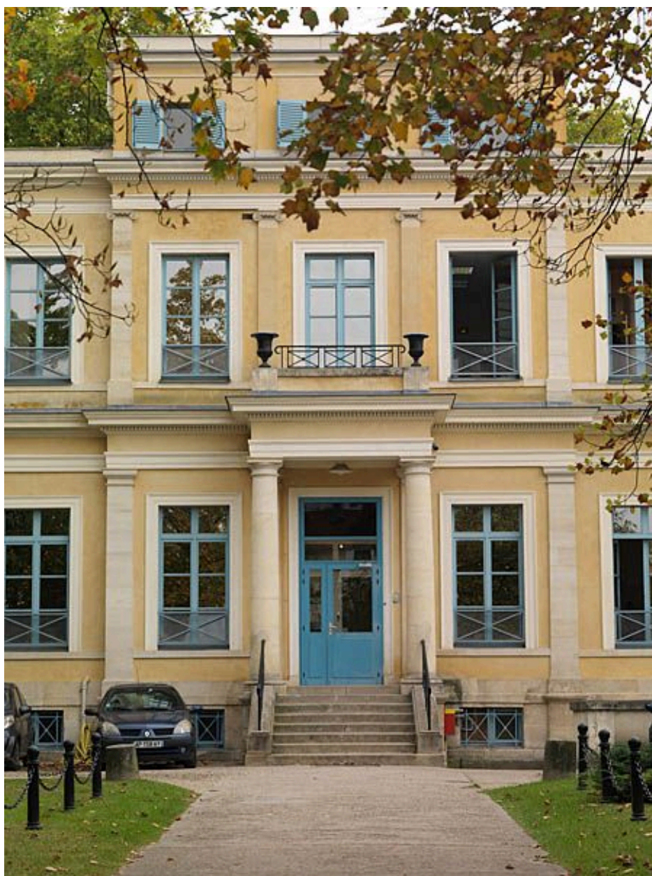
Choisy-le-Roi, maison de maître, 23 boulevard des Alliés. Vue de l'élévation antérieure, détail.
