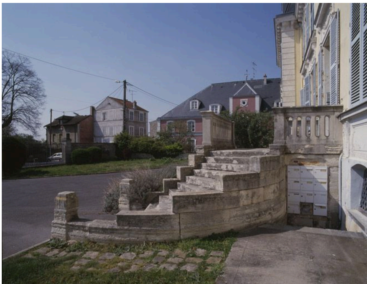
Vue latérale (montée de droite) de l'escalier en fer à cheval situé sur la façade principale.
