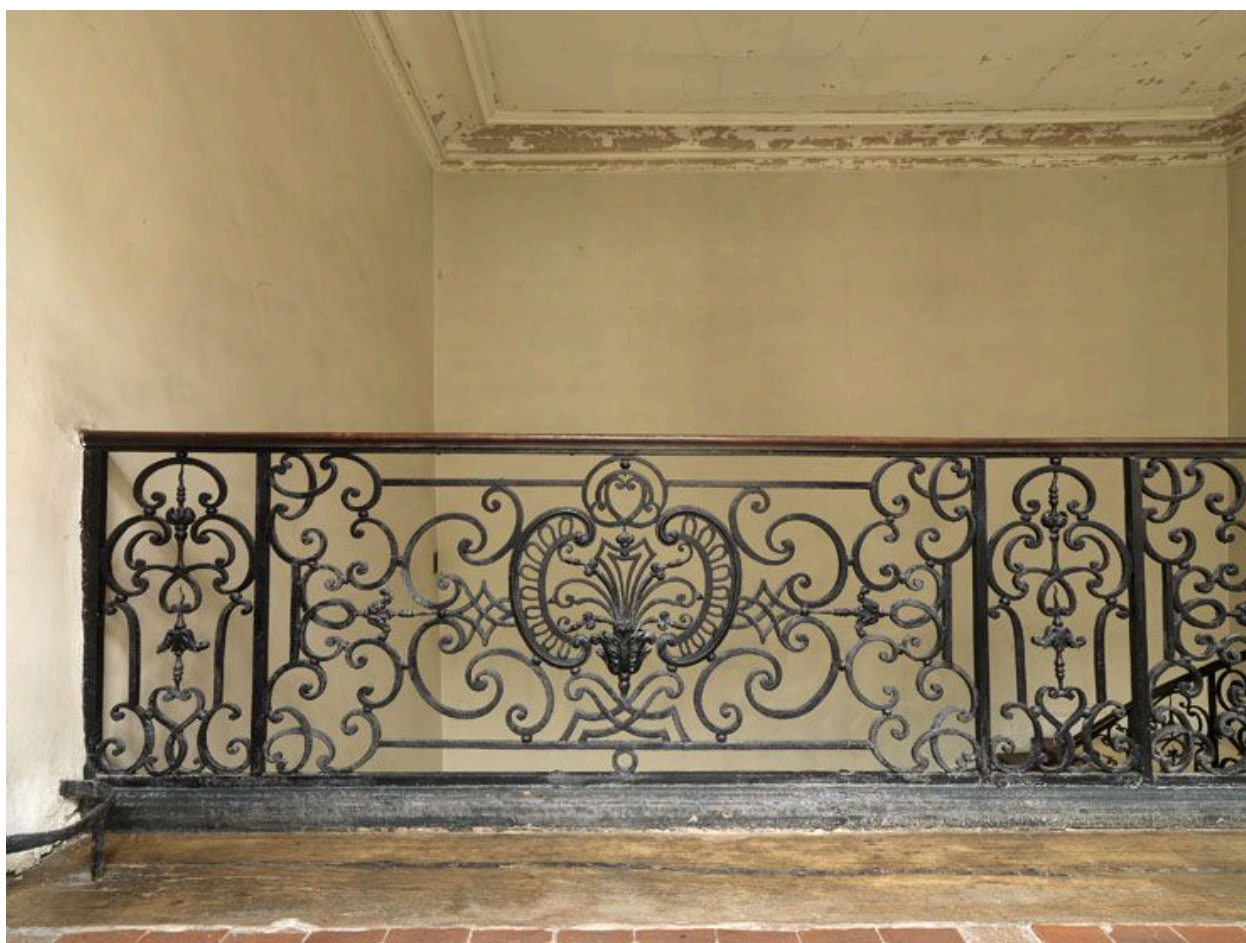
Escalier principal : le panneau droit du dernier palier.
