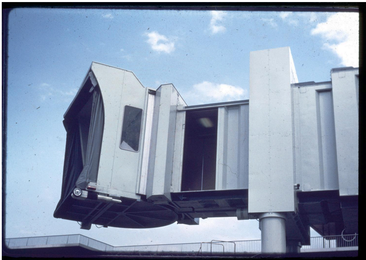
1970, les premières passerelles d'embarquement de l'aéroport d'Orly
