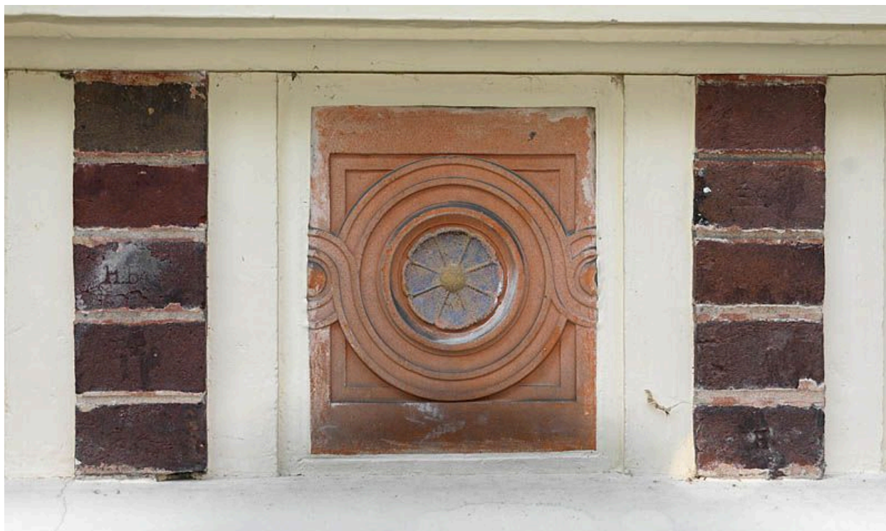
Détail d'une allège de fenêtre, sur le mur oriental de la villa : briques marqués "HB" et carreau décoratif en céramique à motif de rosette centrale.
