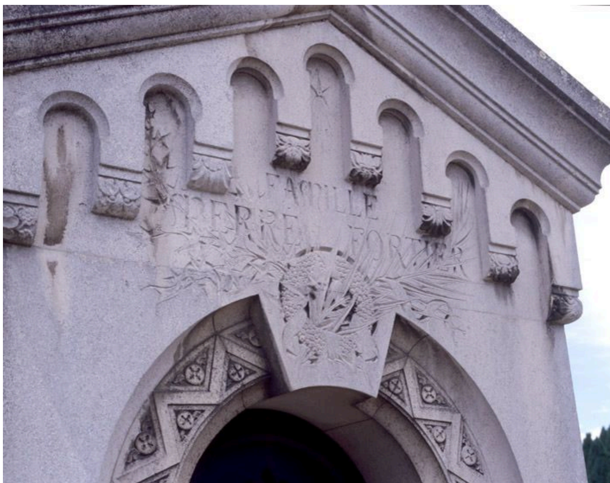
Détail de la façade.
