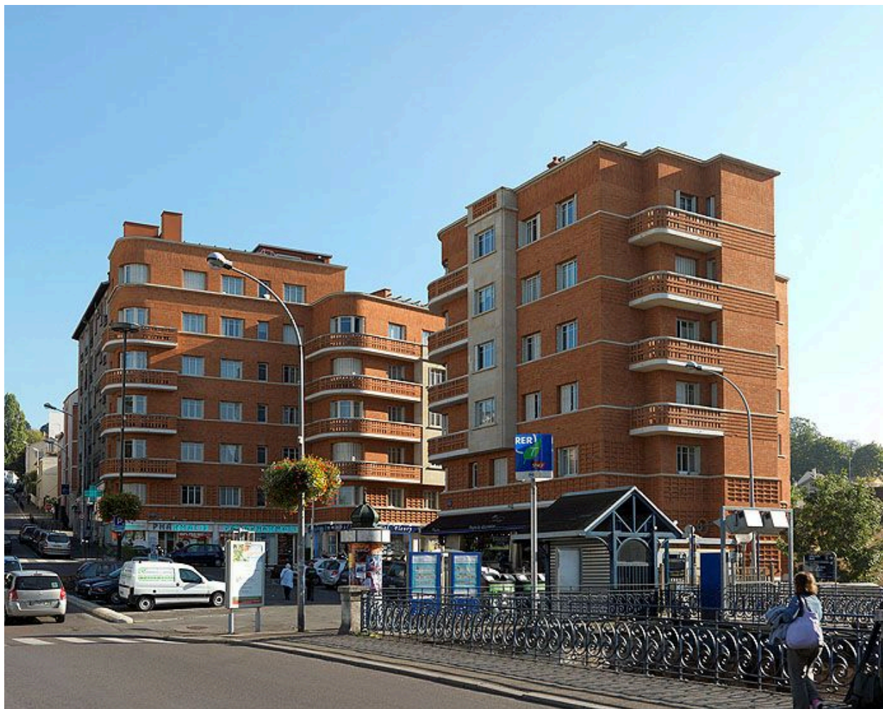
92, Meudon, immeuble, 22-24 place Henri-Brousse. Façades sur la place Henri-Brousse.
