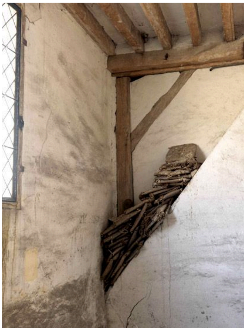
Petite pièce charpentée, attenante au clocher : détail de l'angle nord-est.
