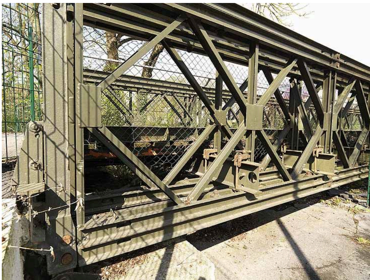
Détail de la structure métallique.
