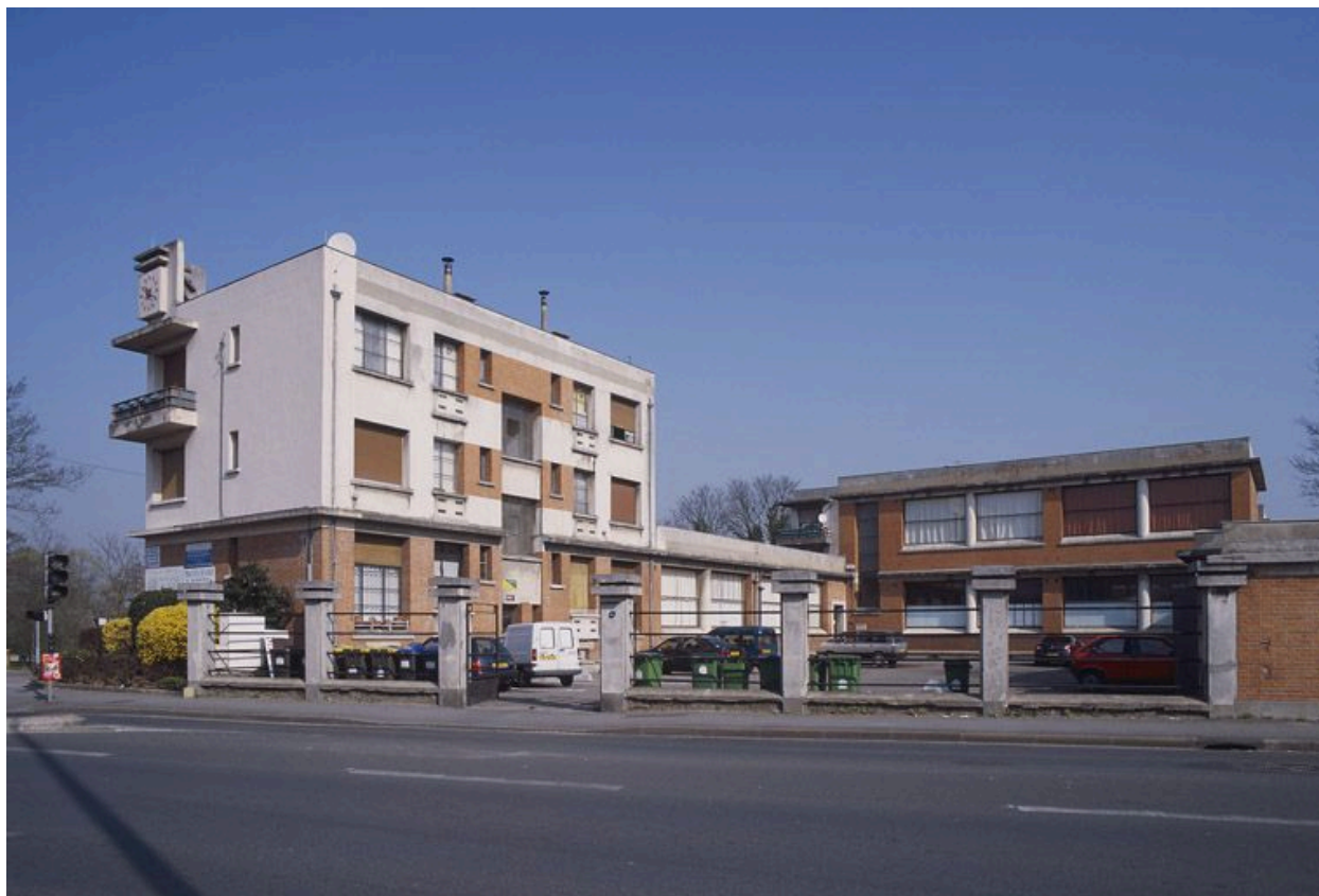
Vue des bâtiments situés le long du boulevard du Général-de-Gaulle.
