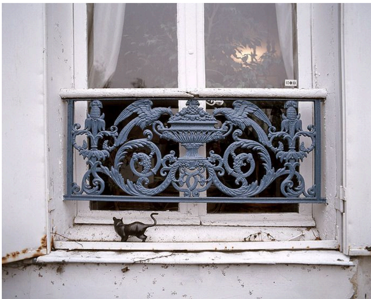
Détail d'un garde-corps en fonte de la façade sur jardin.
