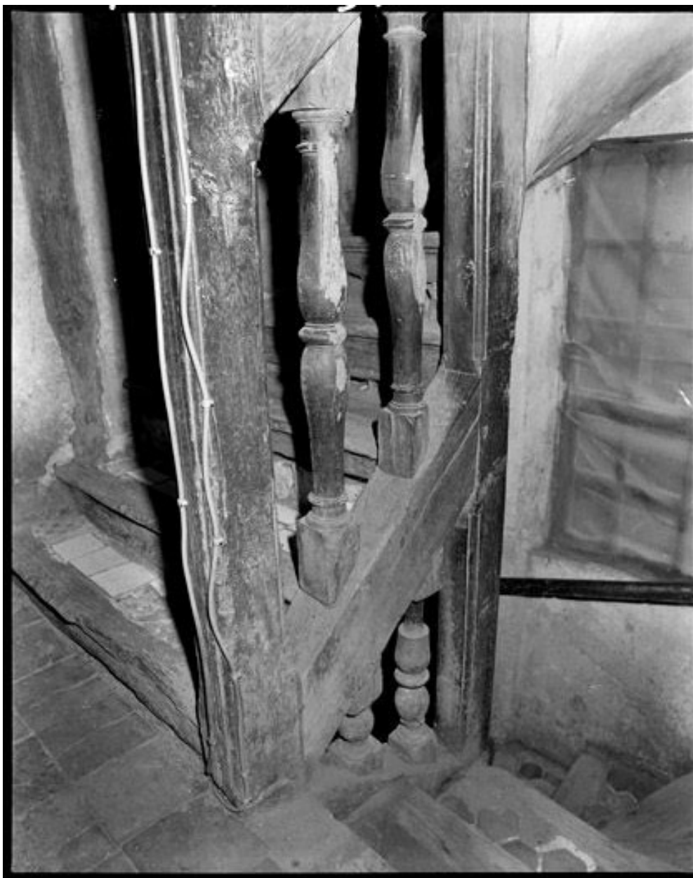
Maison, Sangle (rue de la) 10. Détail des balustres en bois à double poire.
