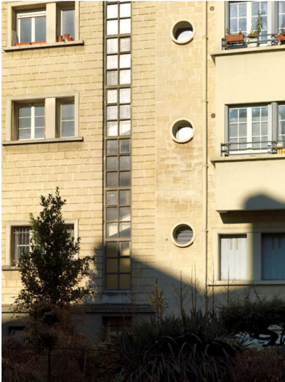
Détail d'une travée d'escalier à l'arrière de l'îlot D.
