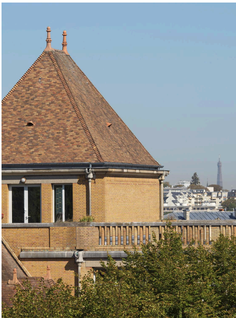
Détail des toitures en pavillon, recouvertes de tuiles plates de Bourgogne.
