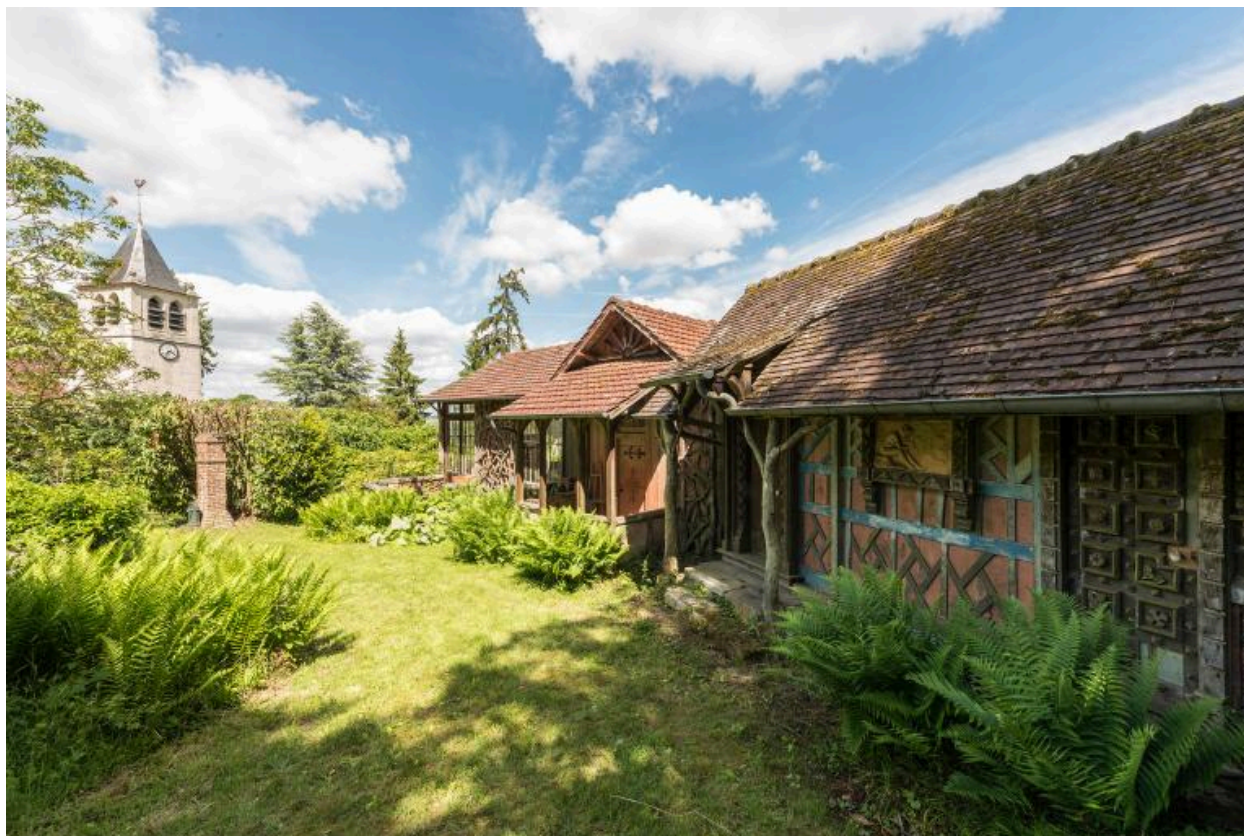
Vue générale des ateliers (4)
