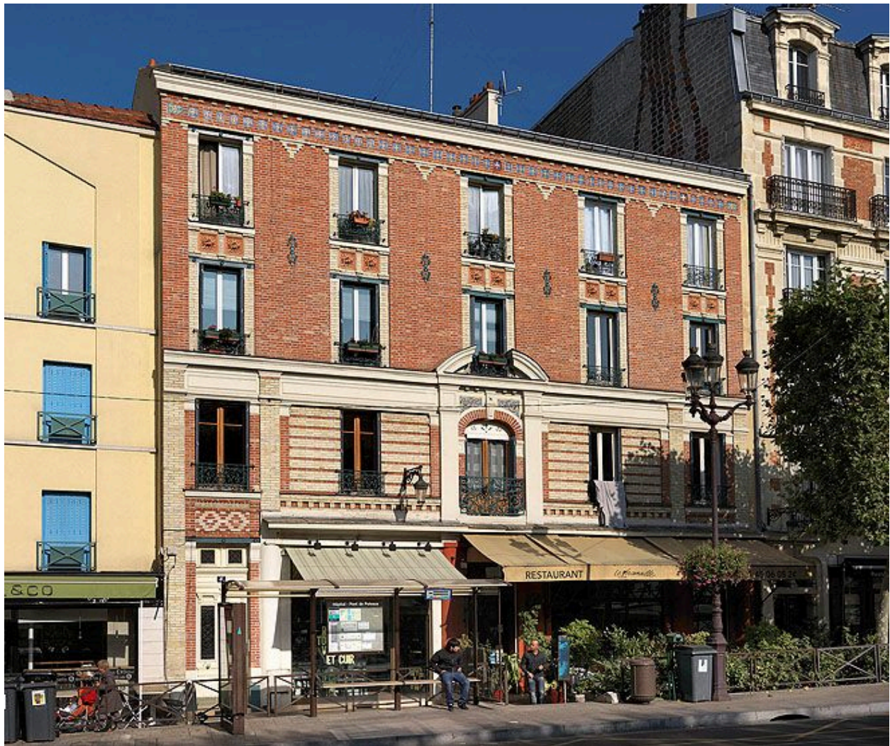
92, Puteaux, immeuble, 6 boulevard Richard-Wallace . Façade postérieure.
